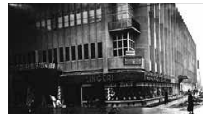
ØLANDSHUS på hjørnet af Amagerbrogade og Ølandsgade (nr. 62) er en af de første store, danske betonbygninger fra 30'erne. Fotograf ukendt - fotoet er fra 1940'erne.
