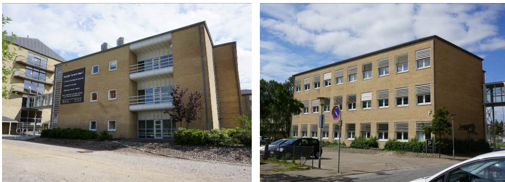
Figur 5 – Den eksisterende bygning set fra hhv. vest og set fra øst
