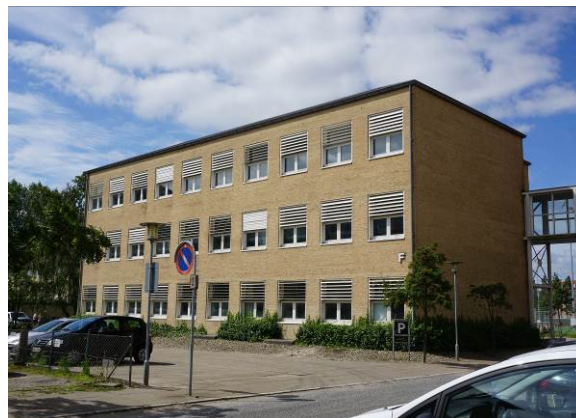
Den eksisterende bygning set fra øst.
