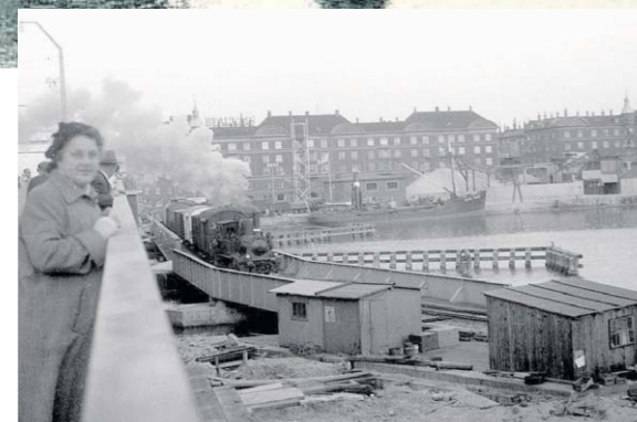
1954. Foto oppe fra den flotte bro med godstogsbroen ved siden af og et rigtigt skib ved Islands Brygge. Foto tilhører Sundby Lokalhistoriske Forening og Arkiv.
